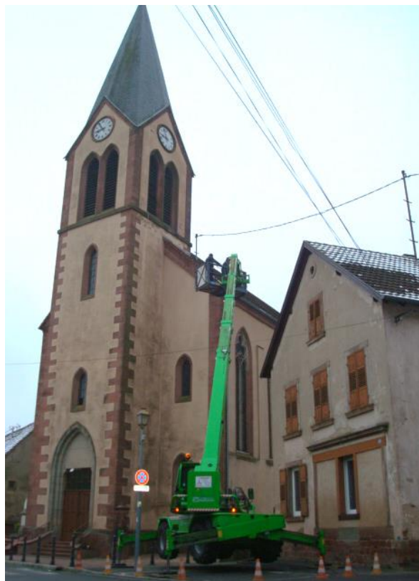
Nettoyage des gouttières de l'église
