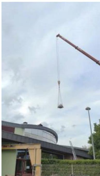
En septembre, en plus des travaux de rénovation de ses bassins, l'Océanide a lancé un important chantier afin de s'équiper de nouvelles centrales de traitement de l'air (CTA), dans le cadre d'un marché global de performance énergétique attribué à ES Energie. Le but de l'opération est d'optimiser le fonctionnement des moteurs de filtration.
