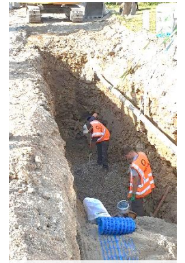
Fossé des réseaux SDEA
